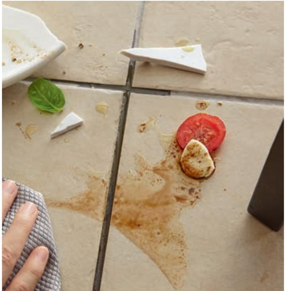
Zementfugen zwischen Fliesen saugen Flüssigkeiten und Öle ein und verfärben sich oft dauerhaft.
