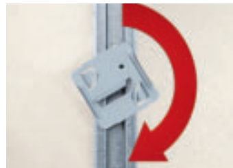
Klipp schräg einsetzen und eindrehen.
